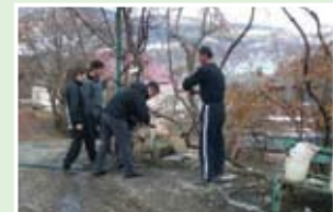
Жители бузалинской общины открывают кран после успешного проведения труб, подводящих воду до села, Джавский район, май 2012.
